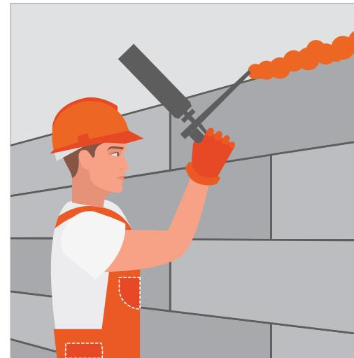
Если высота последнего ряда меньше высоты блока, распиливай блок так, чтобы остался зазор между стенкой и потолком 20-40 мм. Зазор запенивается, либо заполняется шнуром типа «Вилатерм», после чего зачекивается раствором.
