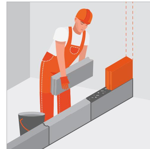
Начинай второй ряд с половинки, чтобы обеспечить перевязку. Толщина горизонтального шва 10-12 мм.
